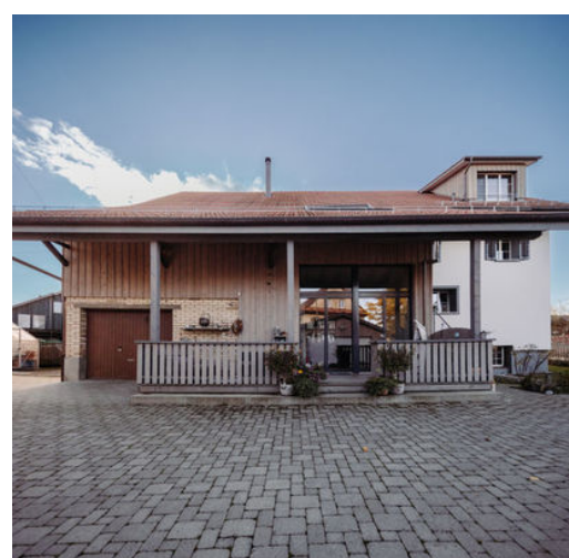
Umbau Bauernhaus Baujahr: 2018
