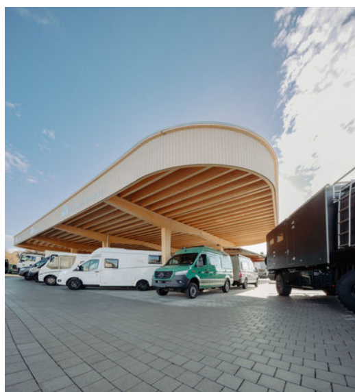
Neubau Reisemobilcarport Baujahr: 2022
